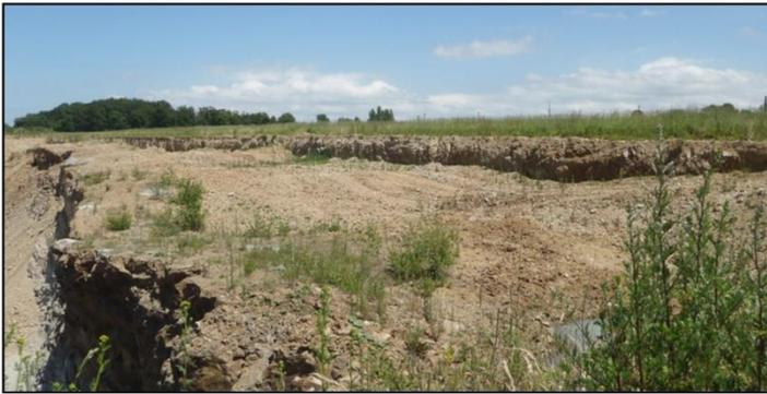
Le décapage de la terre végétale et des stériles non exploitables recouvrant le gisement se fait de façon sélective.
